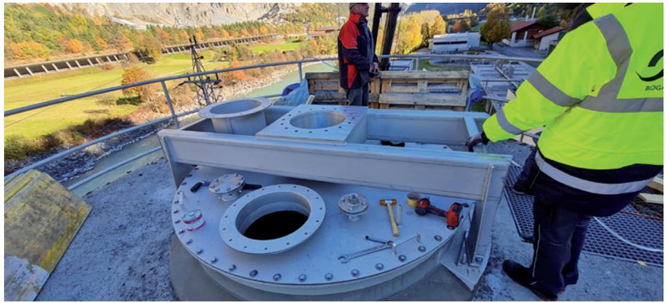
Neue Faulturm Gas-Haube wird montiert
