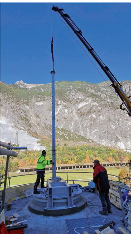
Welle für das neue Rührwerk wird eingebaut
