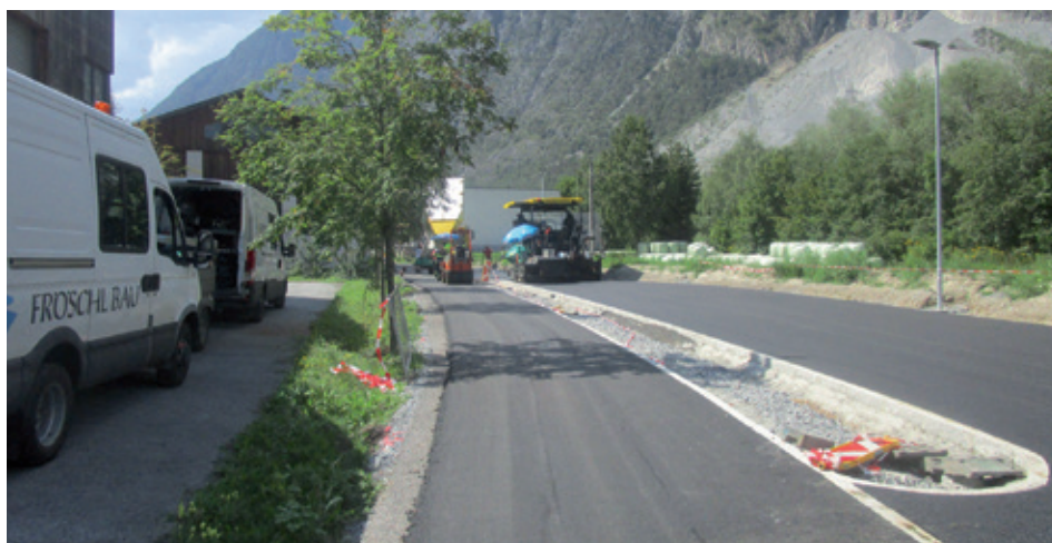
Kurz vor der Fertigstellung
