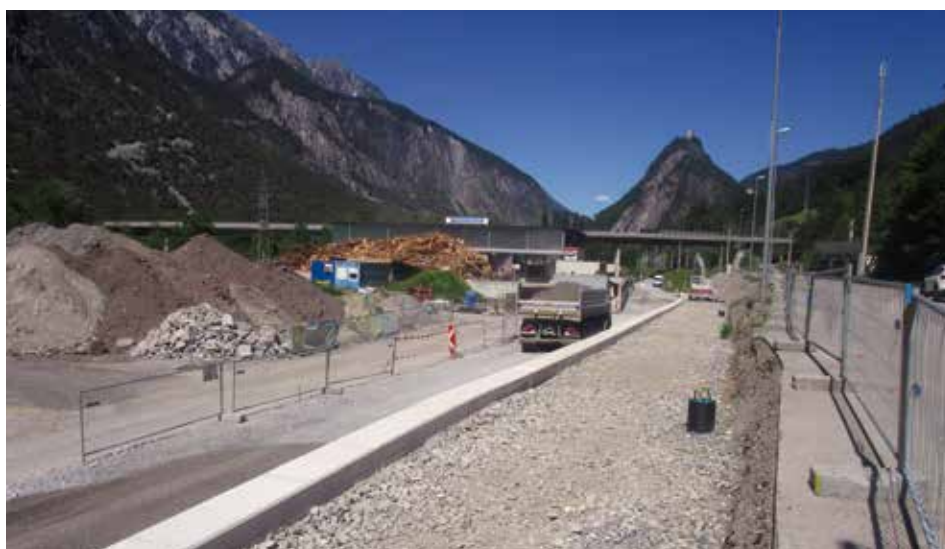
Die neue Zufahrt zum Recyclinghof samt Radweg
